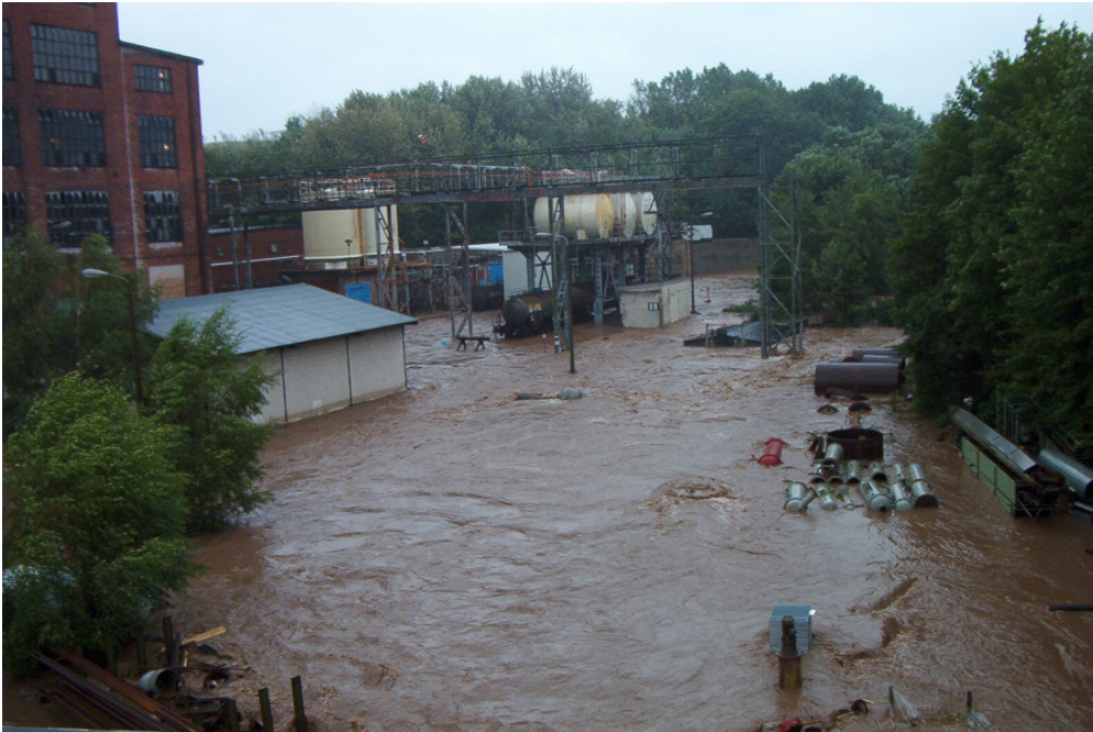
Abbildung 1: Überflutete Chemieanlage in Sachsen
